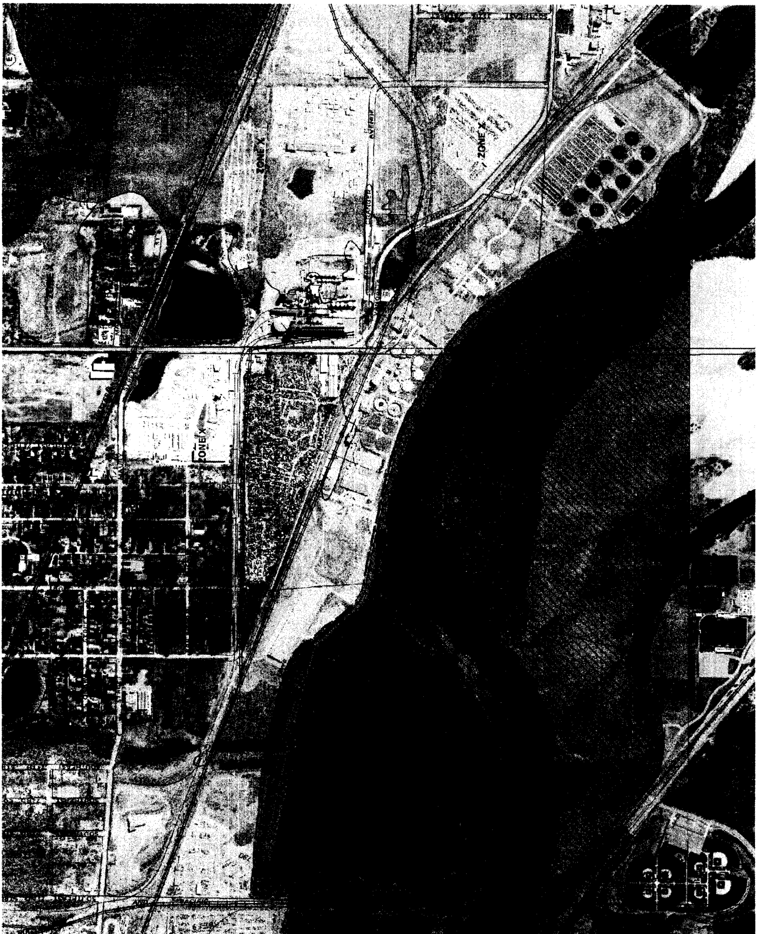
WRA CSSSF Floodway
